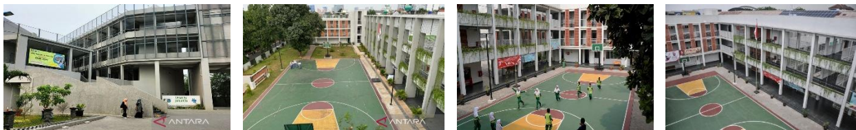
Gambar 1. Gedung sekolah konsep NZEB (kiri-kanan : SMAN 96 Jakarta, SDN Ragunan 08 Jakarta, SDN Grogol Selatan 09, SDN Duren Sawit 14)
