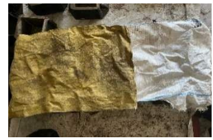
l) Menutup beton yang telah dipadatkan
