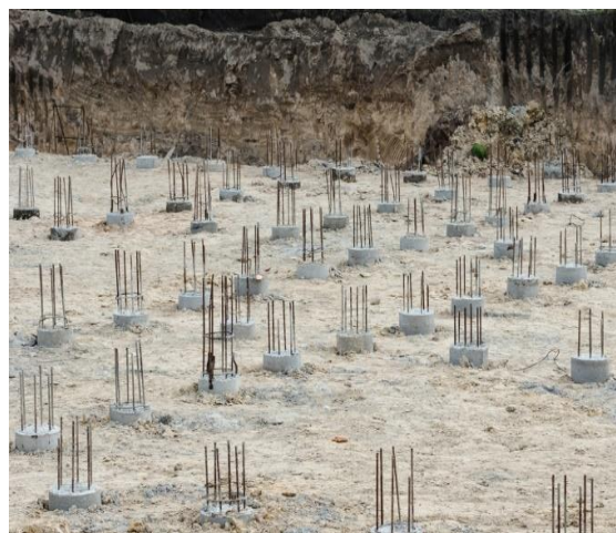
Gambar. 2 Fondasi Tiang Bor Sumber : (Hakam 2008)
