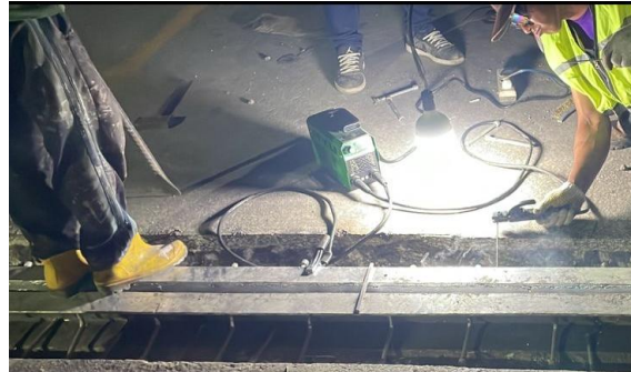
Gambar 7. Proses Pemasangan Sambungan Strip Seal
