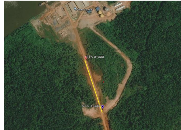
Gambar 7 Trase jalan lokasi uji skala penuh
